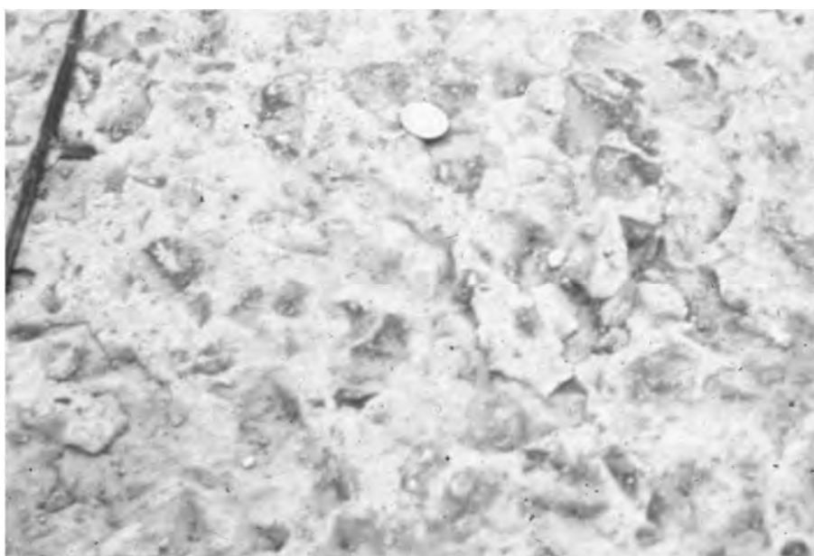
รูปที่ 4-8 การหลุดชะรุนแรง
