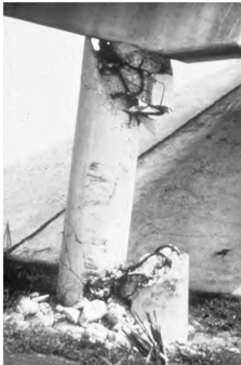
รูปที่ 4-13 แสดงความเสียหายจากการชนของเสาคอนกรีต
