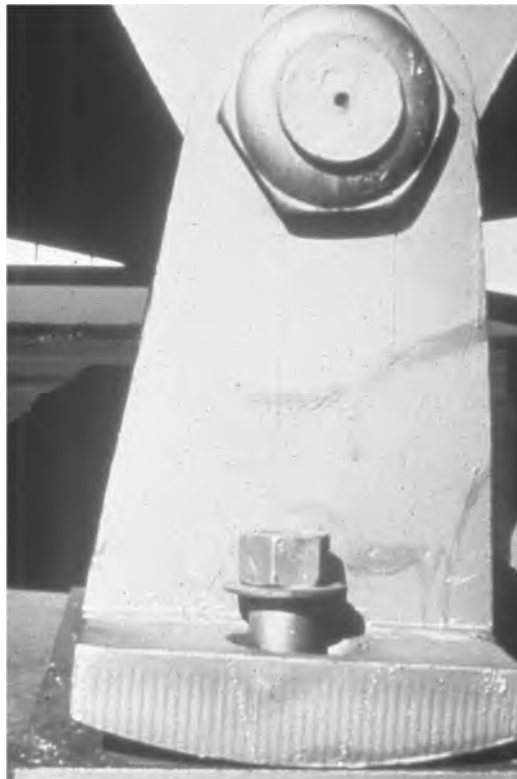
รูปที่ 4-29 แสดงตัวโยกแบบหมุด (Pinned Rocker Bearings)
