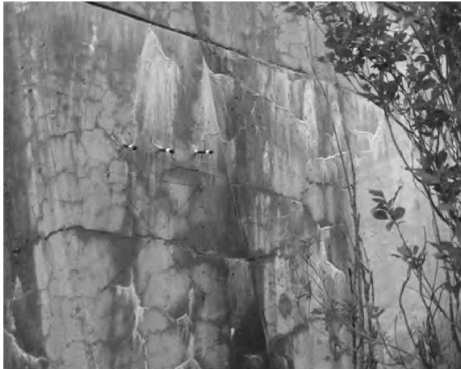
รูปที่ 4-11 แสดงปฏิกิริยาอัลคาไล-ซิลิกา Alkali Silica Reactivity (ASR)
