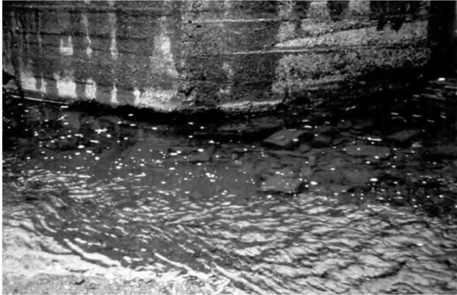
รูปที่ 4-14 แสดงความเสียหายจากการสึกกร่อน
