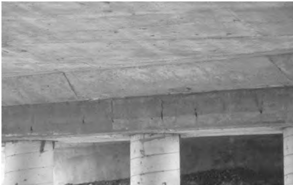
รูปที่ 4-26 บริเวณที่เกิดแรงเฉือนที่ด้านล่างของสะพานพื้นต่อเนื่องใกล้เสา
