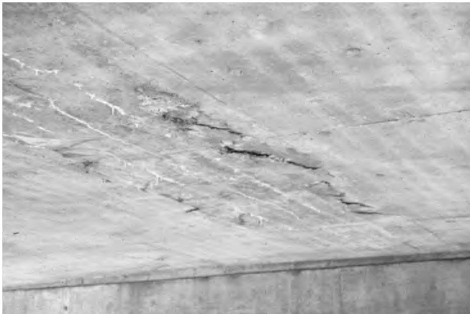
รูปที่ 4-27 แสดงบริเวณที่เกิดแรงดึงของแผ่นพื้นคอนกรีต: การหลุดลอก คราบสีขาว สนิม และคราบ
