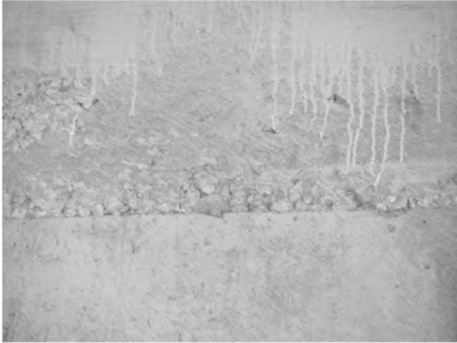
รูปที่ 4-12 แสดงการเป็นโพรงแบบรังผึ้งของคอนกรีต
